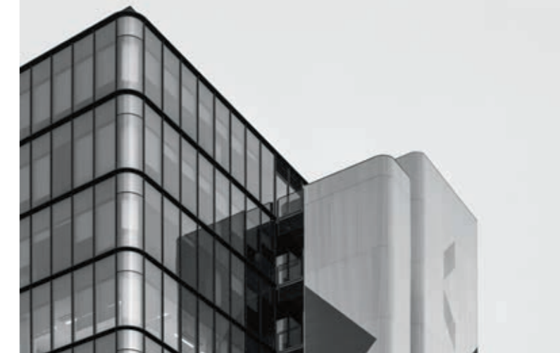
Sarca 235, edificio per uffici in Viale Sarca a Milano. Photo di Delfino Sisto Legnani.
